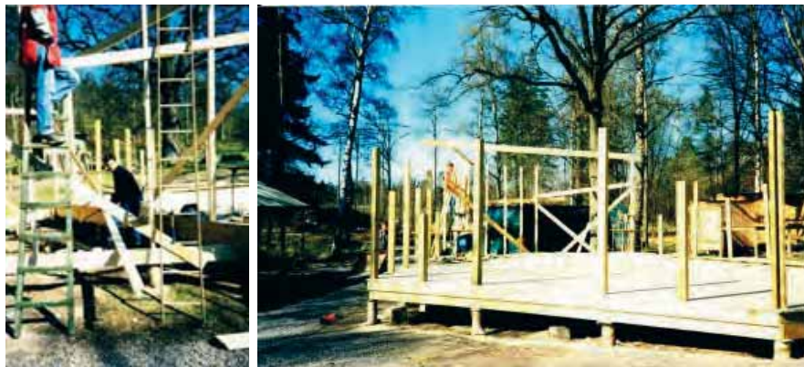
Dansbanan som den såg ut under ombyggnaden. Rune Norbeck hjälper till med bygget. Fotografer okända.
